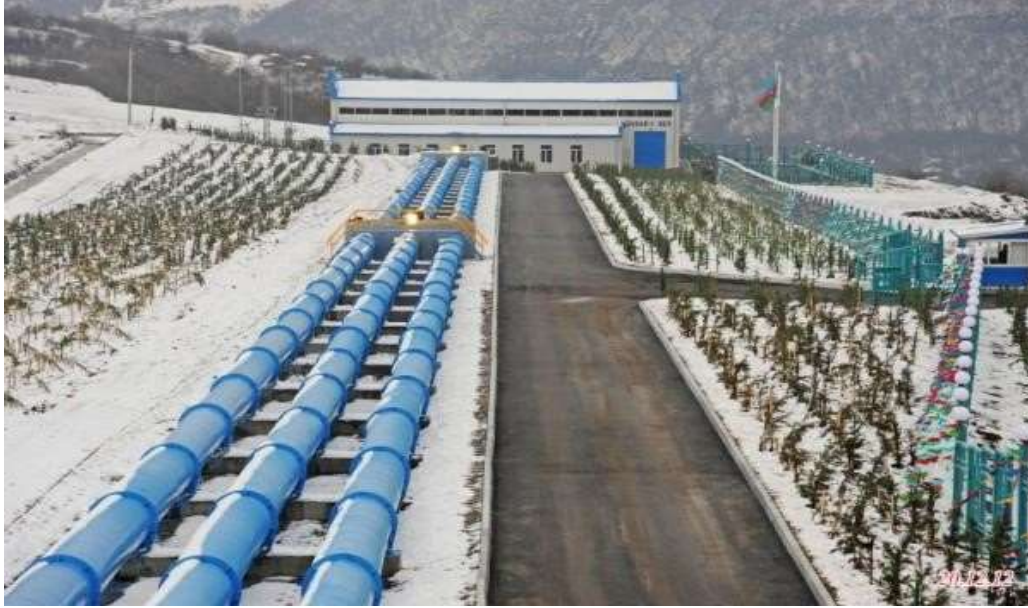
Şəkil 2. Qusar- 1 basqılı Derivasiya komponovkalı KSES
