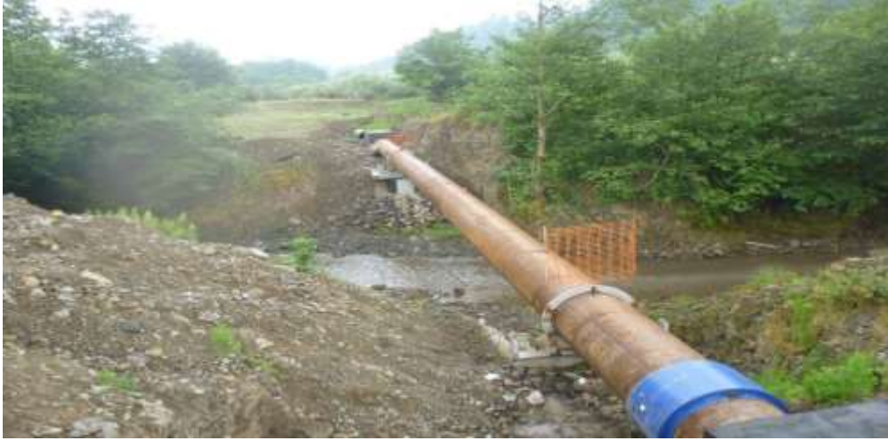
Şəkil 3. Astara – 1 basqılı derivasiya komponovkalı KSES
