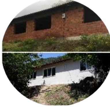
Şekil 9: İşçi Evi Renovasyonu (Resimler: OFI)
